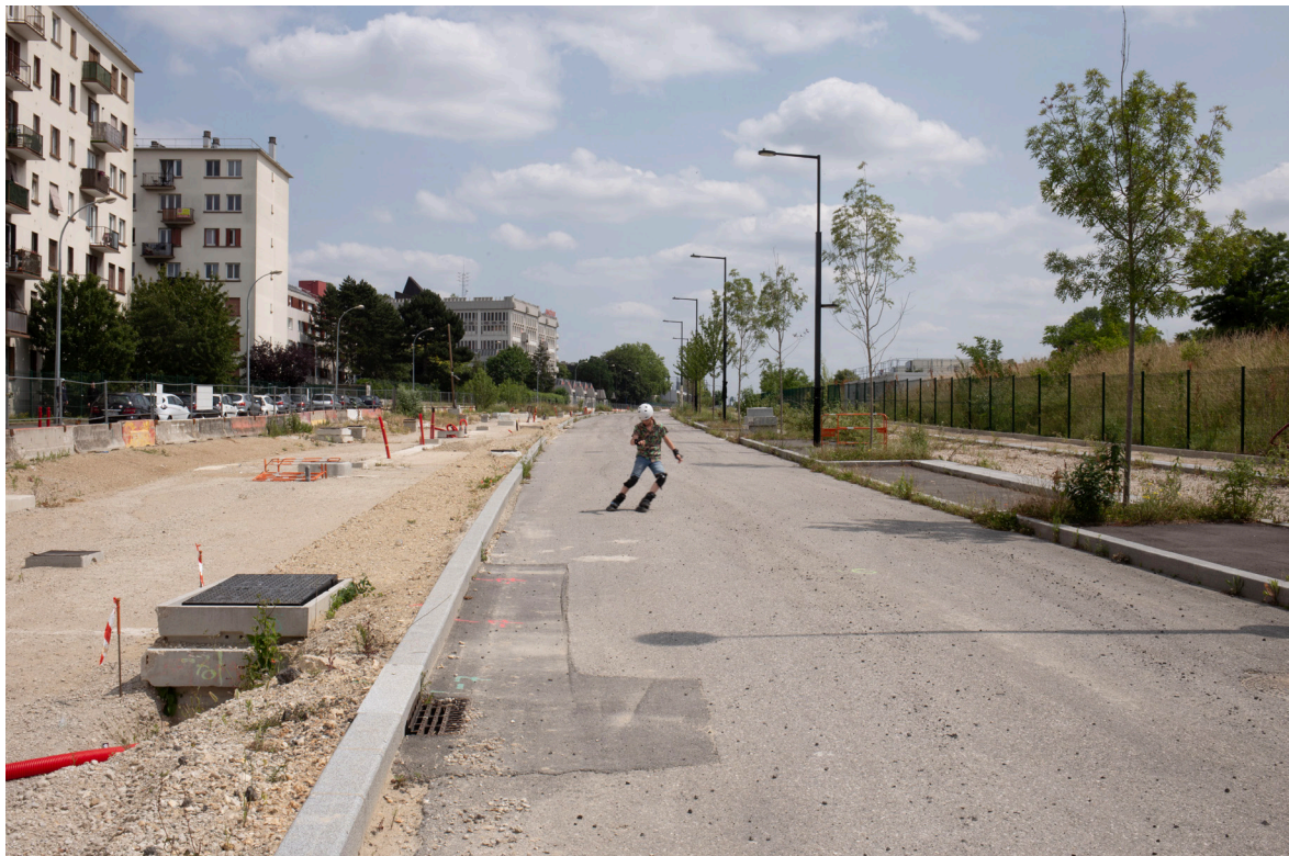
Tram, roller et espace de liberté - Montreuil, 9 juin 2025. Chantier du T1.
