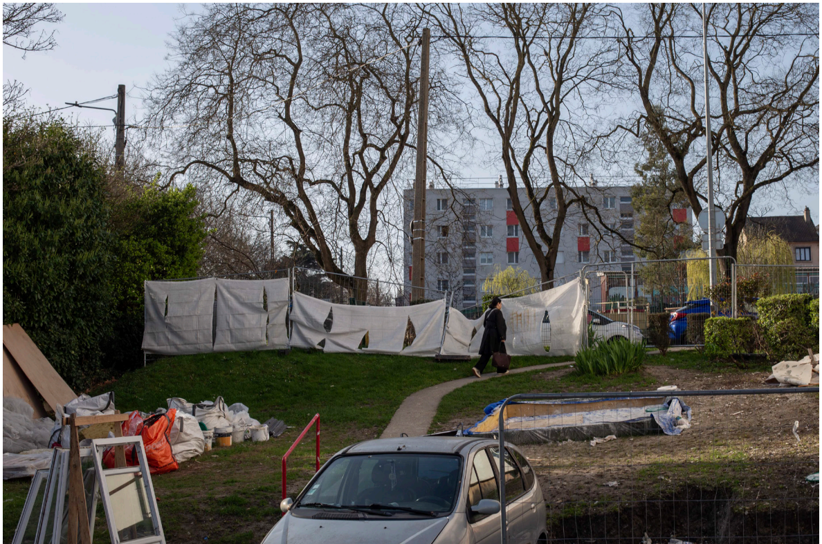
“barrières de chantier, chemin et échappatoire”
