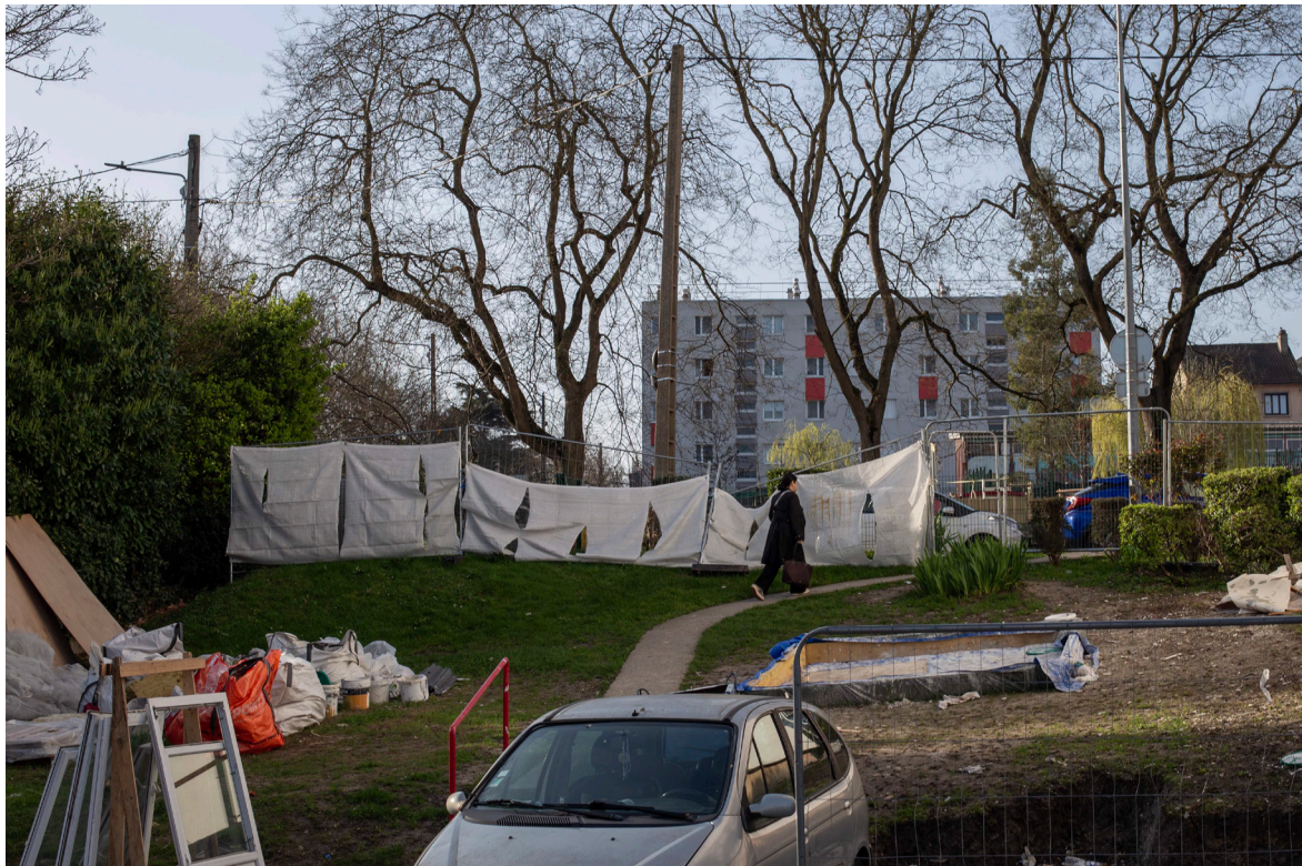
“barrières de chantier, chemin et échappatoire”
